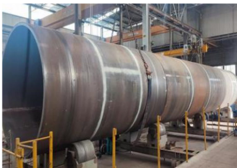
Un tratto della condotta all'interno del cantiere della Snam
